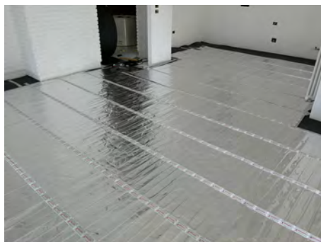
Riscaldamento in alluminio Warmset sotto a pavimento flottante
