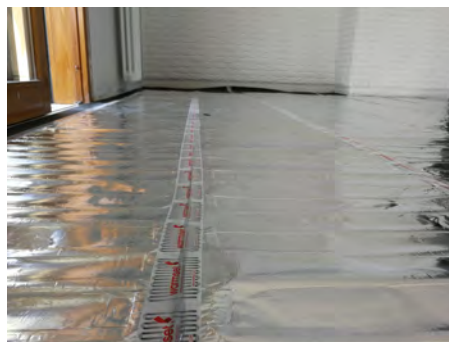
Riscaldamento in alluminio Warmset sotto a pavimento flottante
